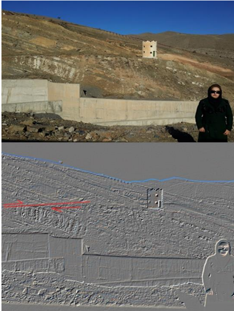
شکل ۱۱- گسل خوردگی شیب‌لغز معکوس در نزدیکی سد شهرچای
