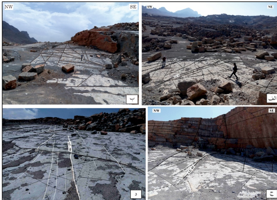
شکل ۱۰: نمایی از ایستگاه‌ها در برداشت شکستگی‌ها با راستای غالب در بررسی صحرایی در مجموعه معدنی سنگ ساختمانی لاشتر الف- ایستگاه ۱ شکستگی‌های با امتداد ۹۰ درجه ب- ایستگاه ۴ شکستگی‌های با امتدادهای شمال شرقی- جنوب غربی، شمال غربی- جنوب شرقی ج- ایستگاه ۹ شکستگی‌هایی با امتداد شمالی- جنوبی و شرقی- غربی د- ایستگاه ۱۶ شکستگی‌ها با امتداد شرقی- غربی و ۱۳۰ درجه.
