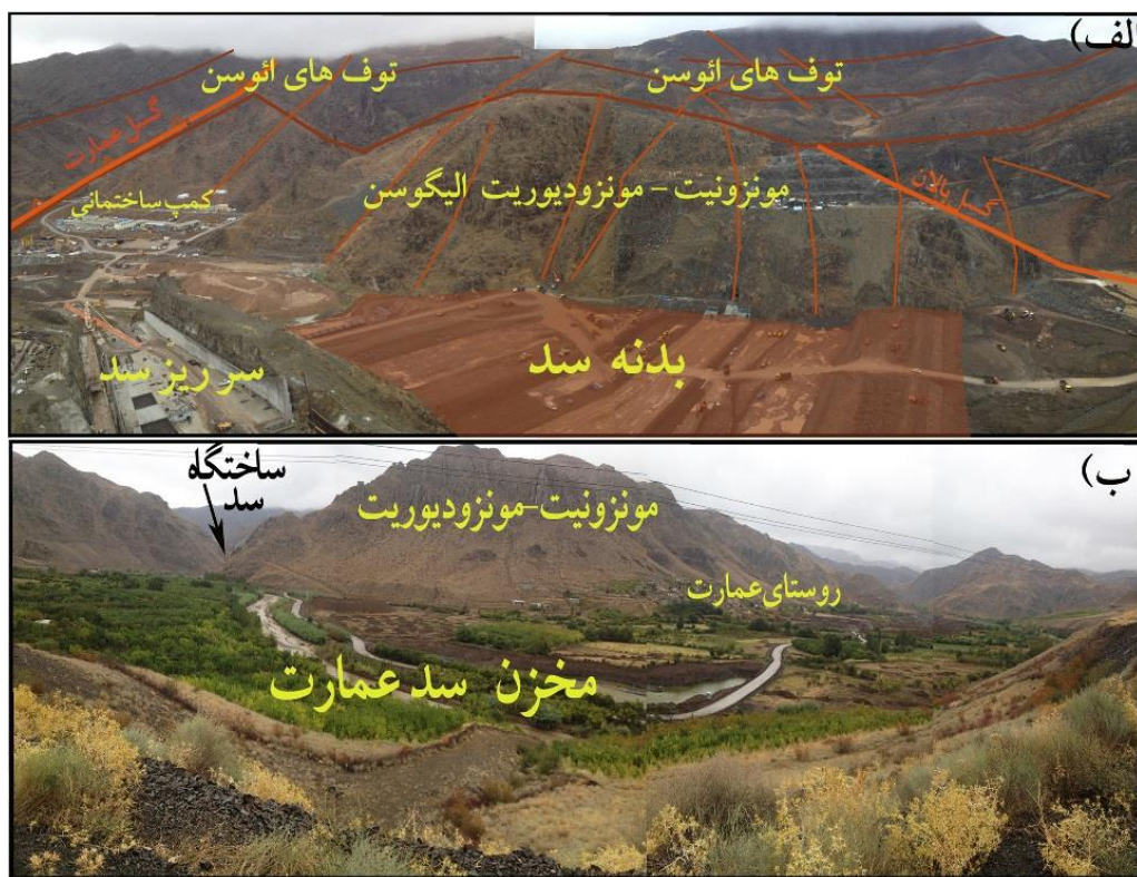
شکل ۲: الف- تصویر پانوراما از محل ساختگاه سد، به وضعیت قرار گیری گسل‌های اصلی و زون‌های خردشده توجه شود؛ ب- تصویر پانوراما از محل مخزن سد در حال احداث عمارت
